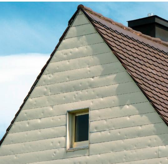
*Durch Hagelschlag verformte Fassadenverkleidung aus Metall*
