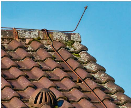
*Fangeinrichtung einer Blitzschutzanlage*
