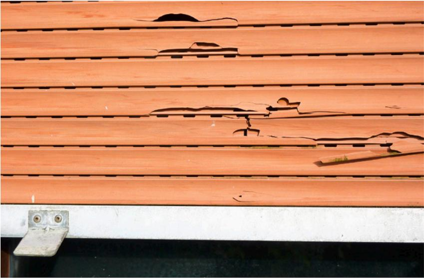
*Beschädigter Rollladen aus Kunststoff nach Hagelschlag*
