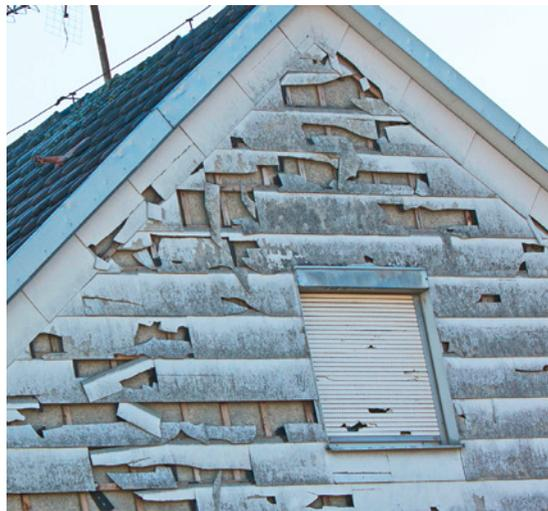
*Durch Hagelschlag bruchgeschädigte Fassadenverkleidung aus Faserzementplatten*
